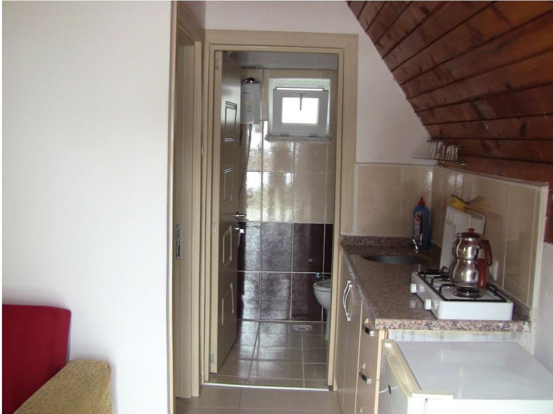
11 Adet Bungalow temizlenerek acil onarımları yapıldı.
