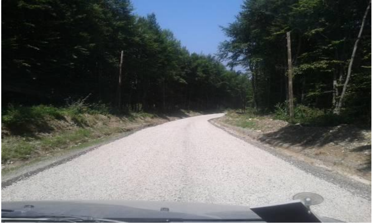
Erfelek Kirazlık Köyü 1 ve 2. Kat Asfalt Çalışması
