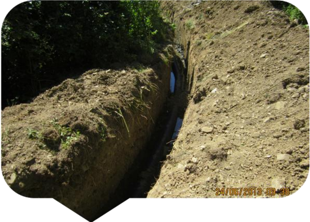
KANALİZASYON HATTI ÇALIŞMASI
