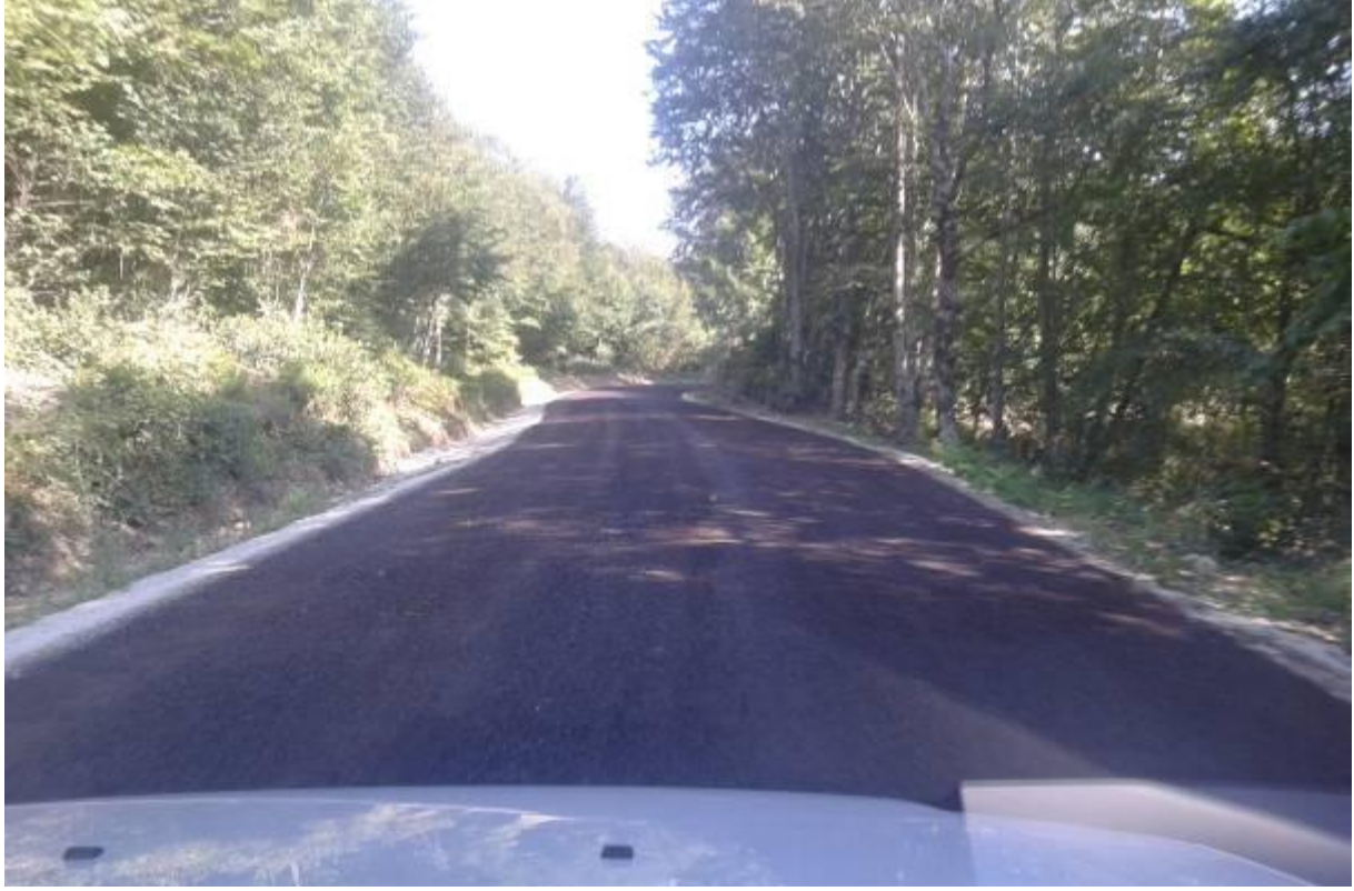
Erfelek Gümüşsuyu Köyü 1.Kat Asfalt Çalışması
