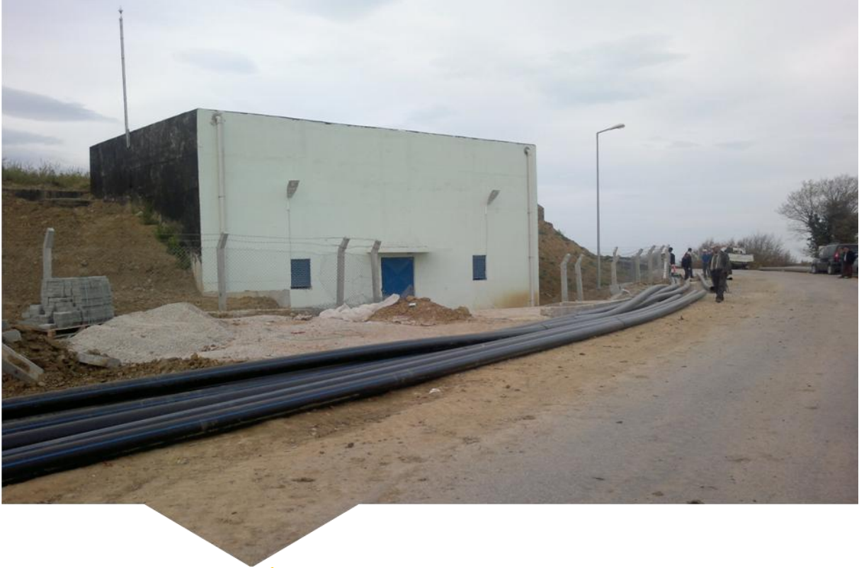
İNCEMEYDAN SUYU DEPOSU
