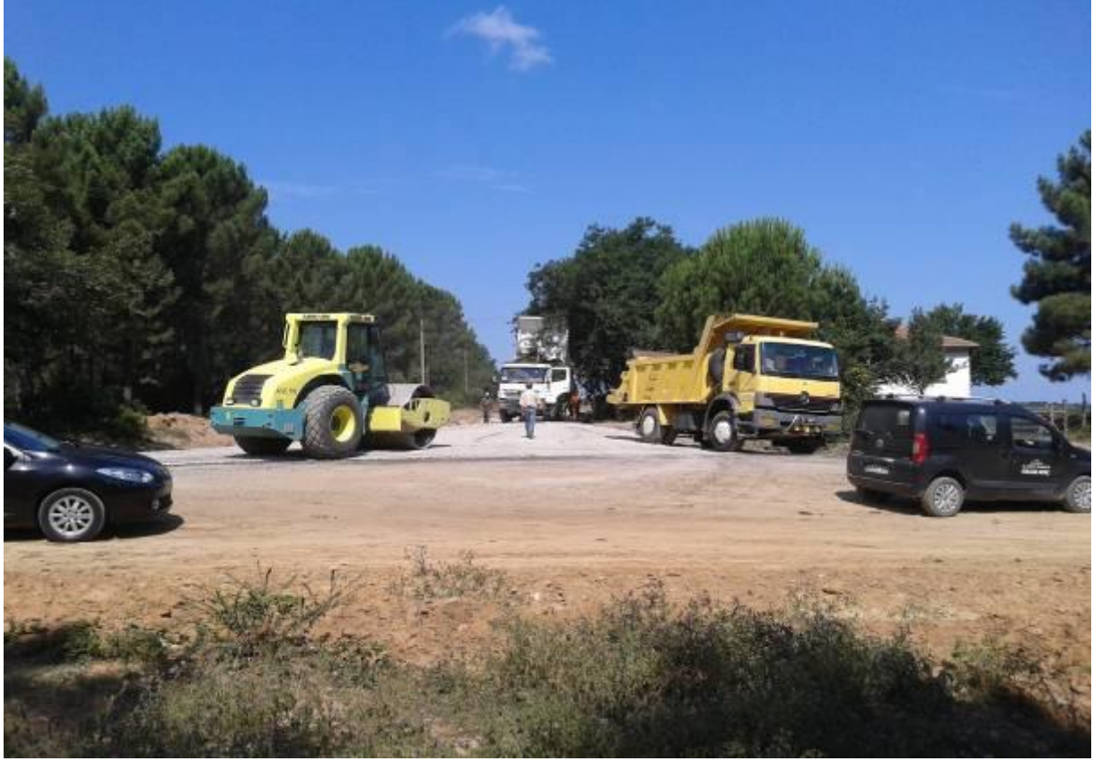
Merkez Abalı Köyü Asfalt Çalışması
