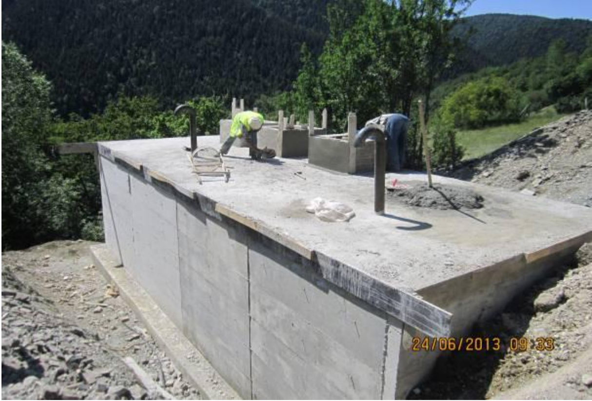
BAŞSÖKÜ KÖYÜ FOSEPTİK İNŞAATI
